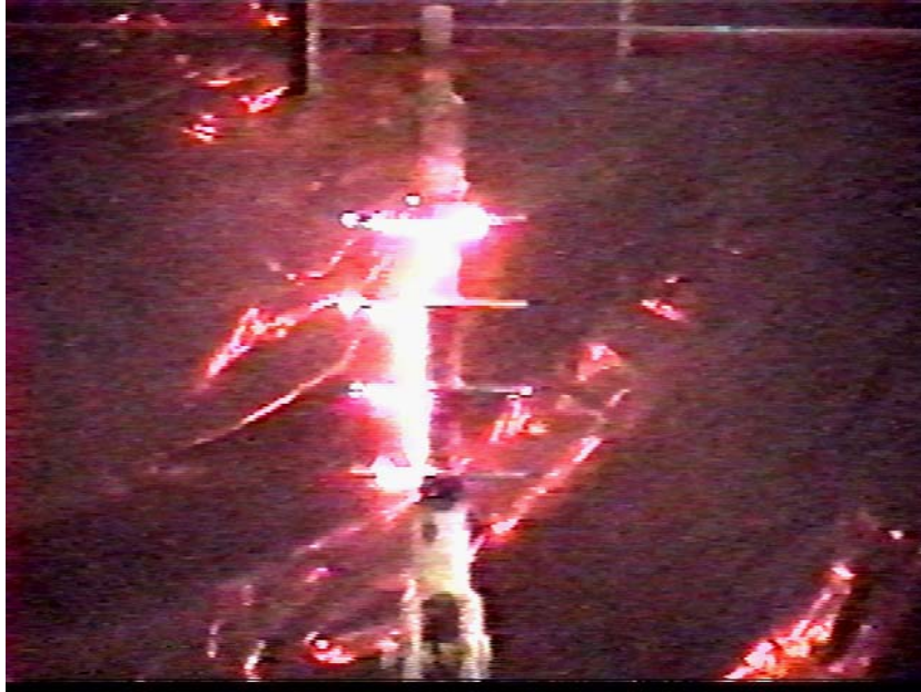
Figura C1. Flameo de un aislador polimérico de EPDM, clase 15, en una cámara de contaminación artificial, para un nivel de contaminación ligero
